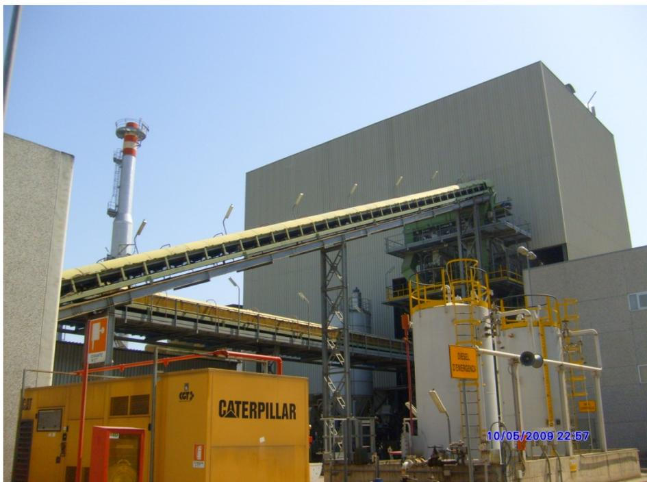
Fig. n. 1.3.5: Sistema di distribuzione combustibile
